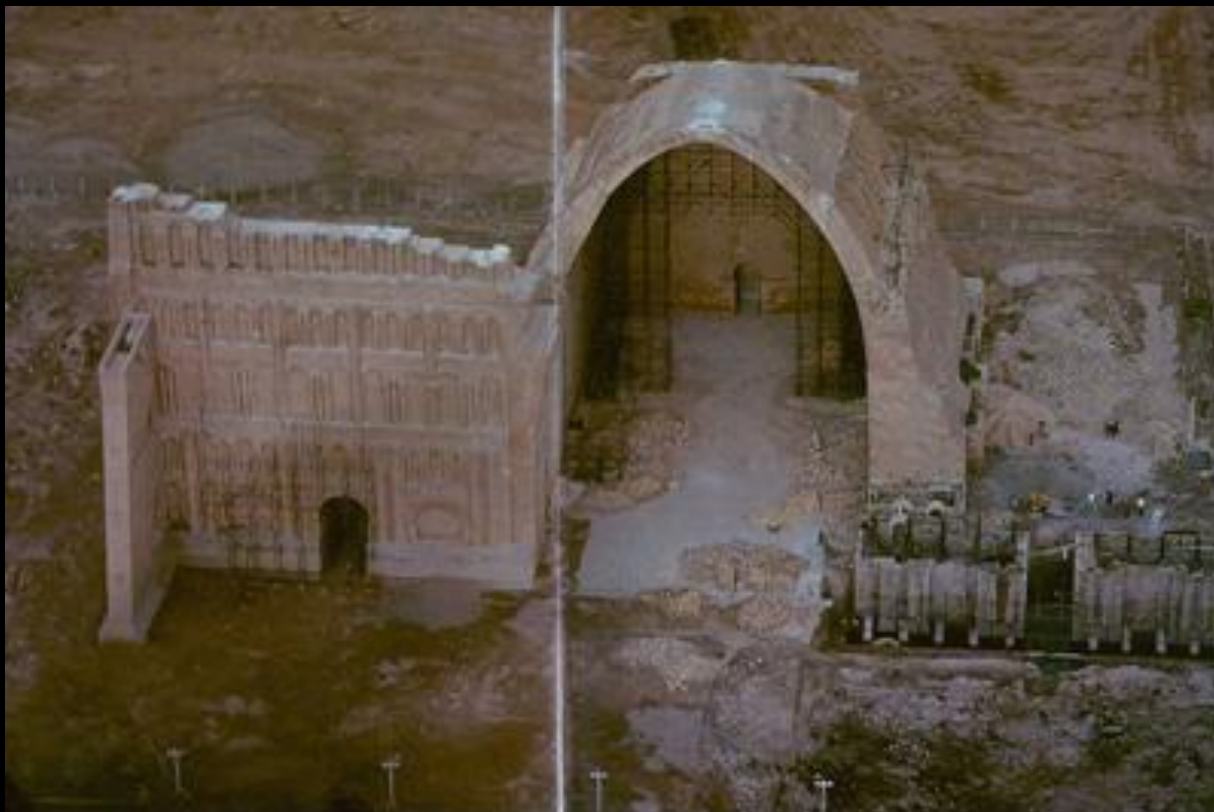
Elevação do grande arco e da fachada sul do Iwān-e Kesra
