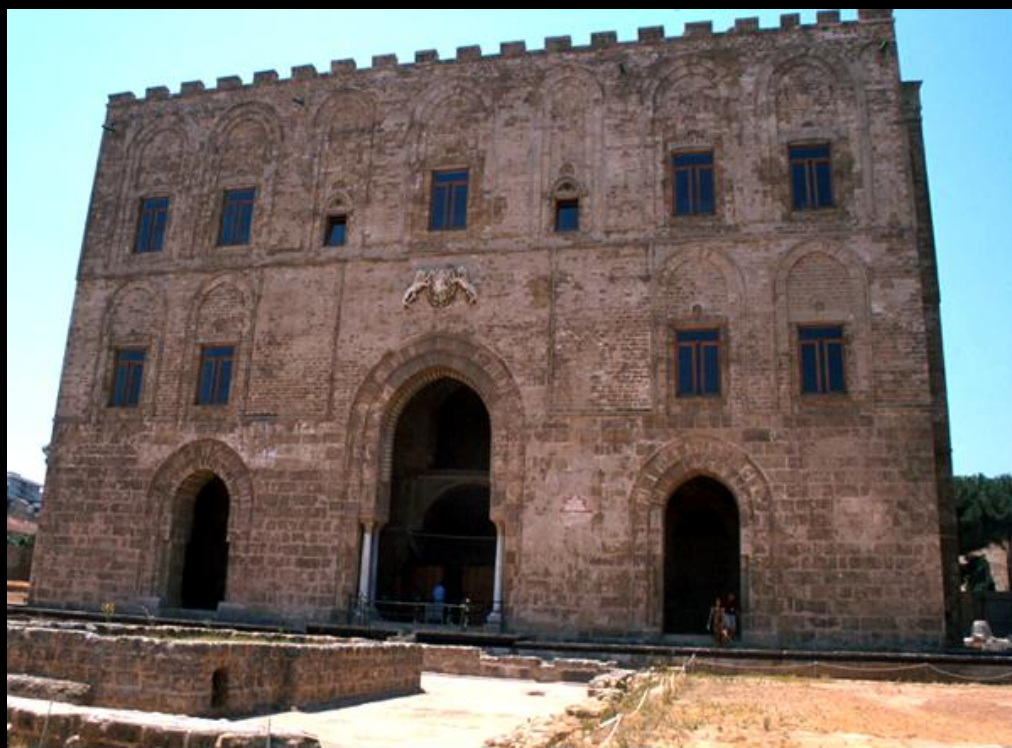
Fachada principal do Palácio de Zisa, Sicília
